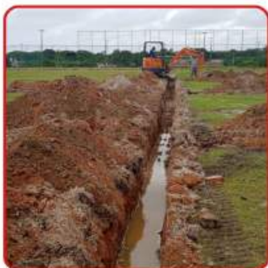
Reforma no sistema de drenagem dos campos da Divisão de Base
